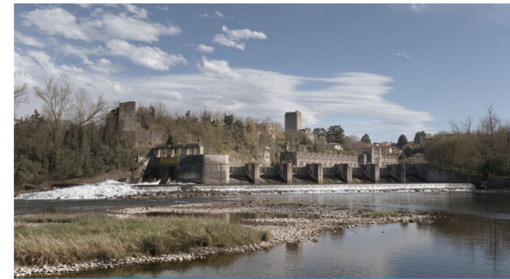
Centrale Idroelettrica Taccanisul Fiume Adda
